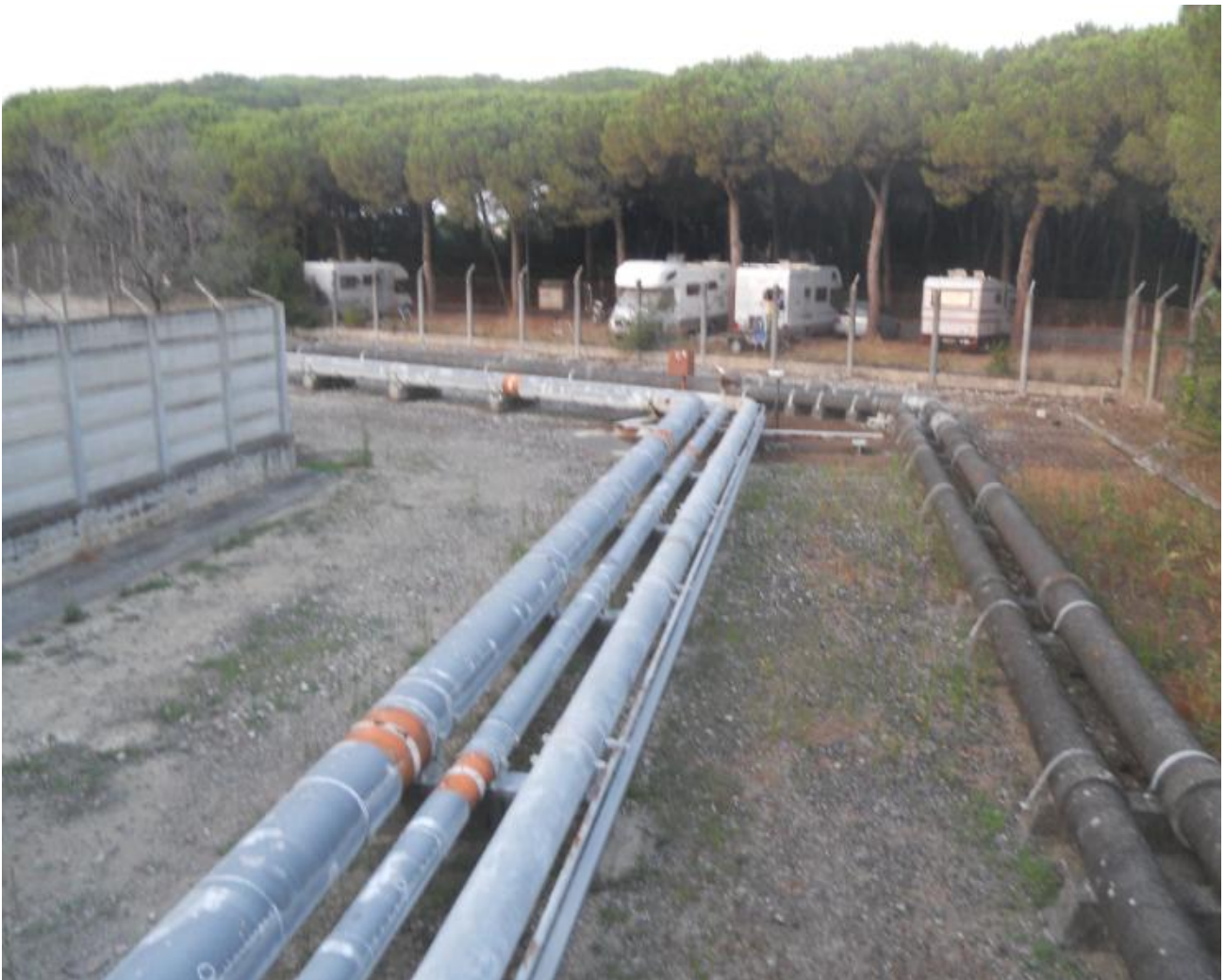
Vada, ecco le tubazioni di etilene liquido (a sinistra), invece a destra le tubazioni che portano la salamoia allo stabilimento. A sinistra, oltre il muro, un piccolo villaggio di lavoratori Solvay. (Foto MD 2013)
